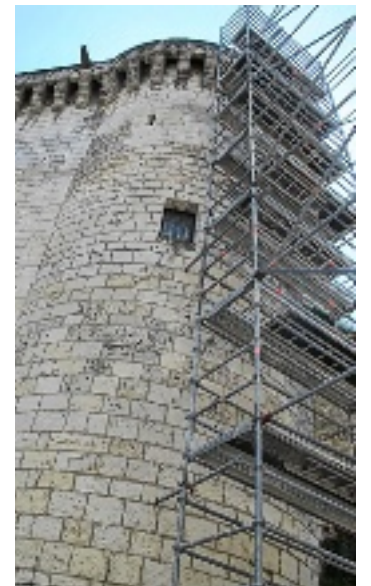
Les travaux ont commencé il y a quelques jours.
